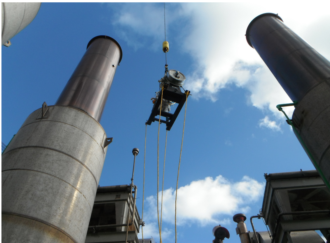
Figura 30 - Içamento da turbina pelo guindaste.
