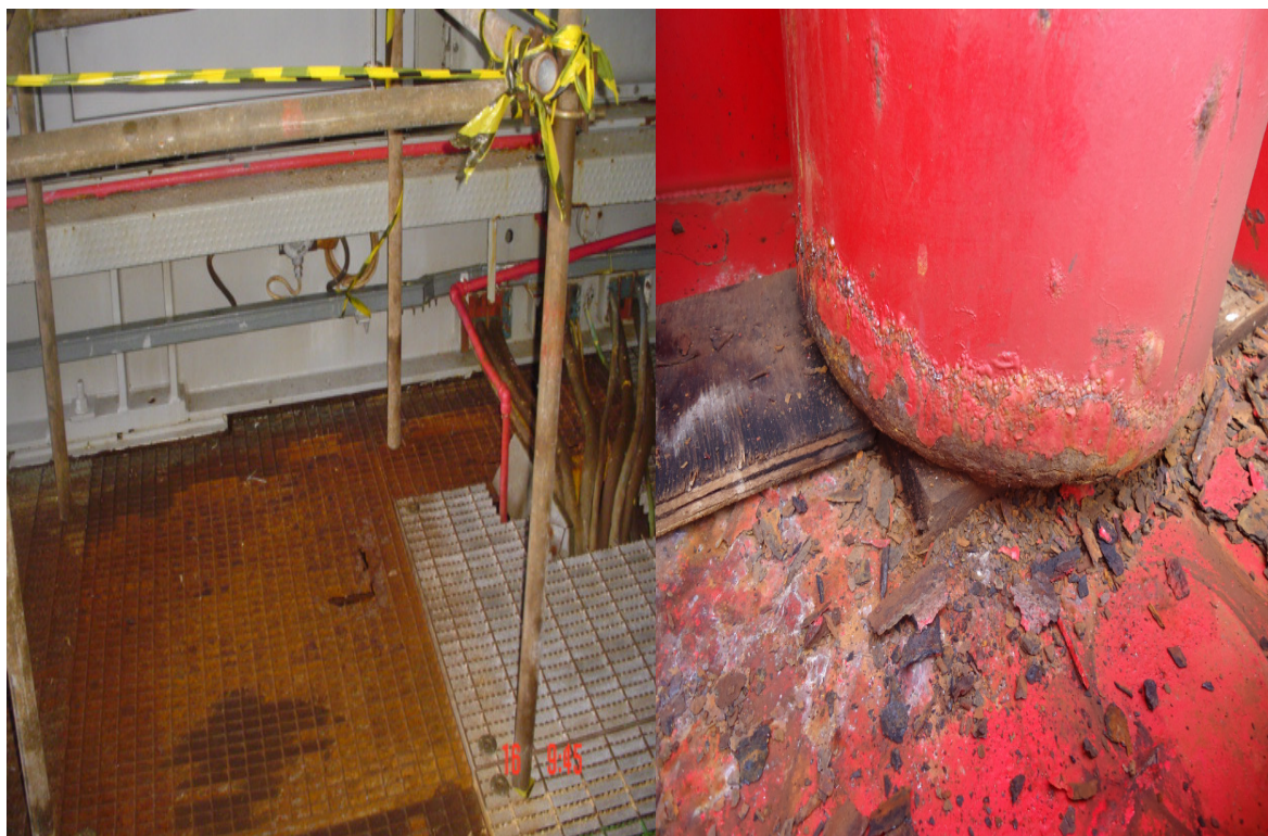
Figura 32 - Efeito da maresia e corrosão.
