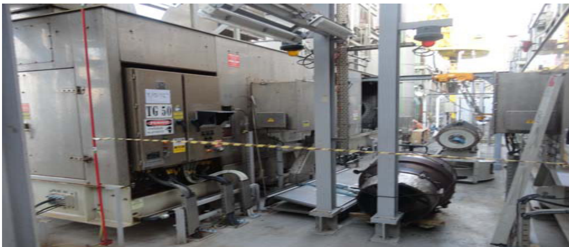
Figura 26 - Isolamento da turbina com fita de segurança.
